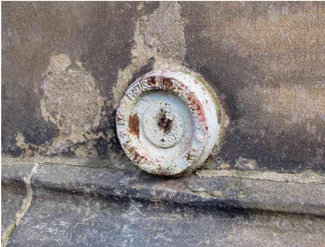
Nivellementpunkt 59 (an der Südfassade der Kirche)
