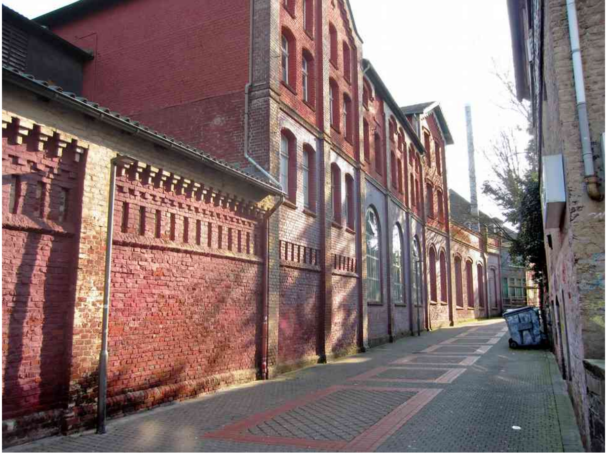
Neumarkt 1 (Ansicht von der Untermauerstraße)
